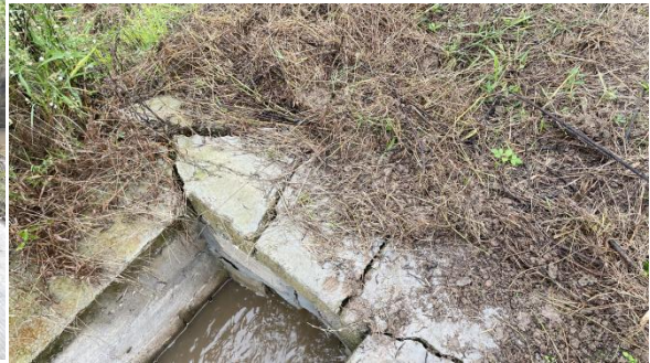
图 5-8 安居区项目区渠道损坏
