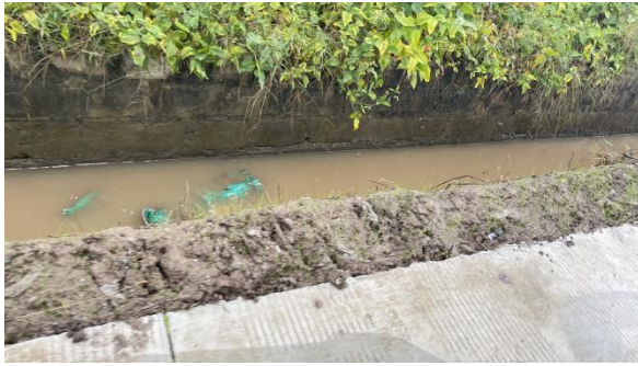
图 5-7 安居区渠道堵塞
