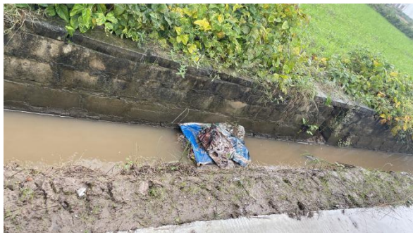
图 5-5 安居区渠道堵塞
